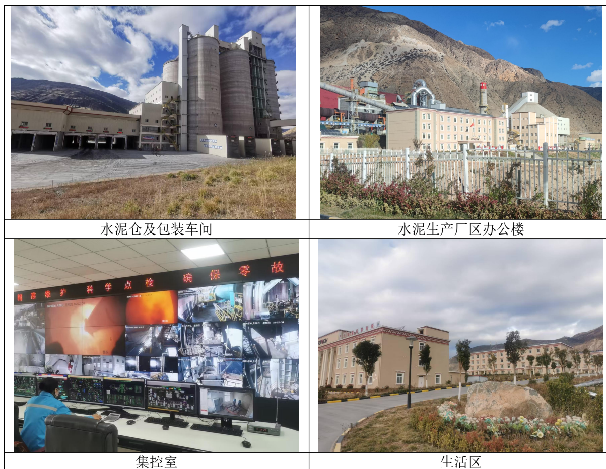
图 2.3-4 现有工程现状照片
