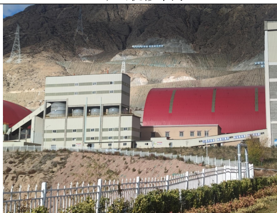
生料配料站+原辅料堆场
