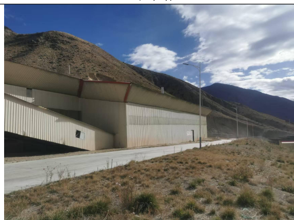
石膏和混合材堆棚
