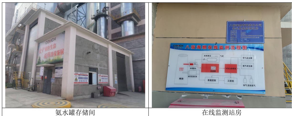
图 2.4-4 现有工程其它环保措施现状照片
