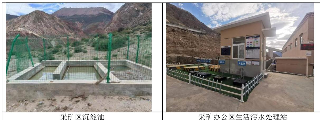
图 2.3-13 现有石灰石矿山废水污染治理措施现状照片
