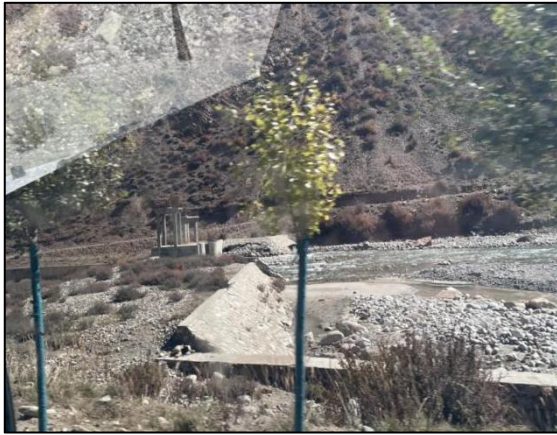
拉绕村取水口
