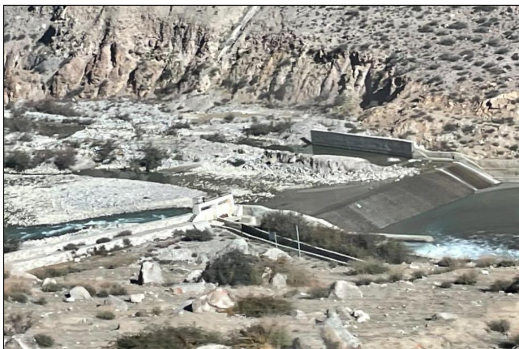
图 4.1-2 八宿县萨漠通灌区取水闸坝
