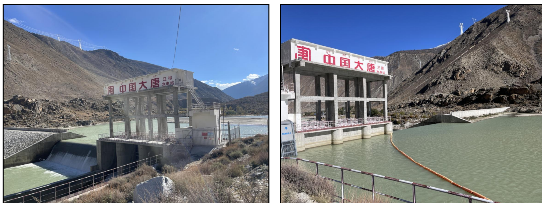
图 4.1-1 八宿县汪排电站站房和水坝
